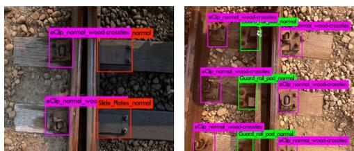
圖 17 YOLO 進行側線辨識結果
