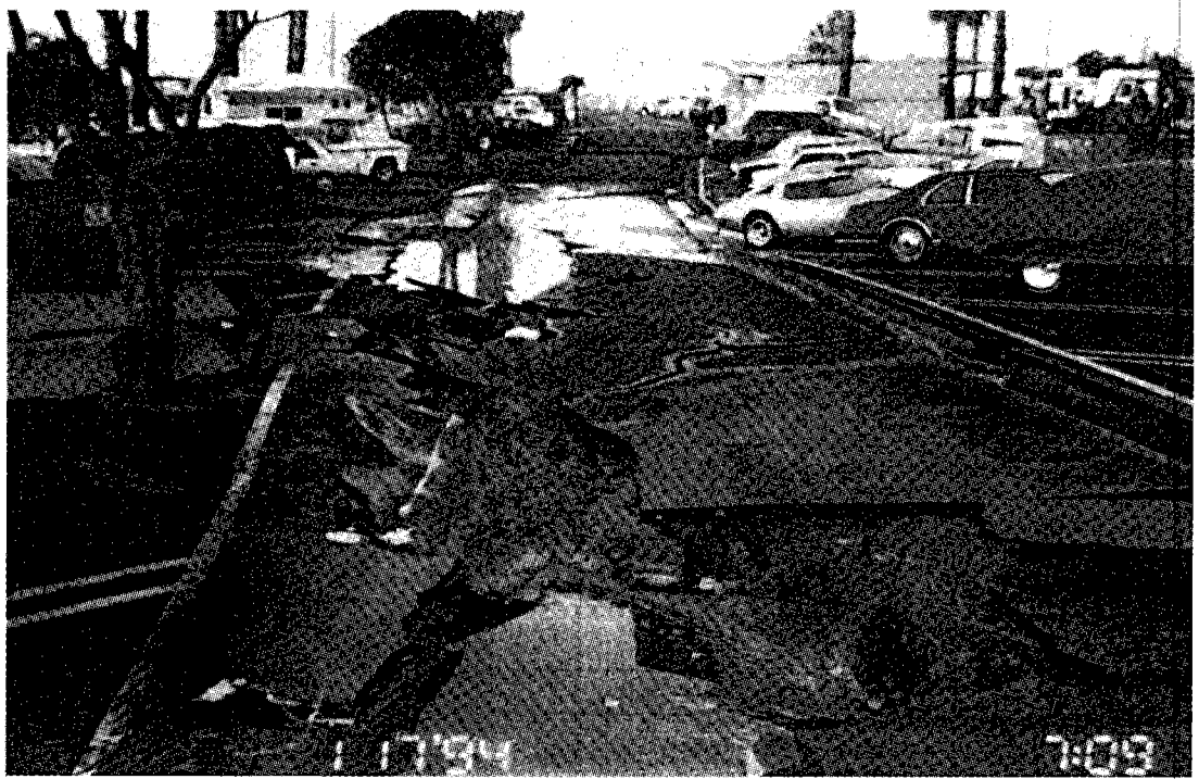
圖 7 B 突堤中央長條形破壞區
